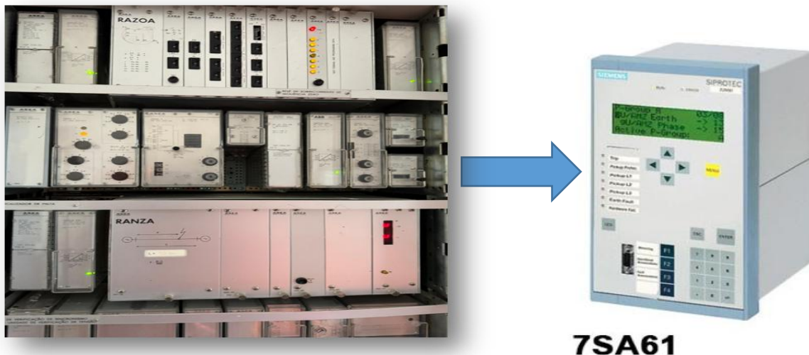
Figura 34: Relé estático vs Relé digital
