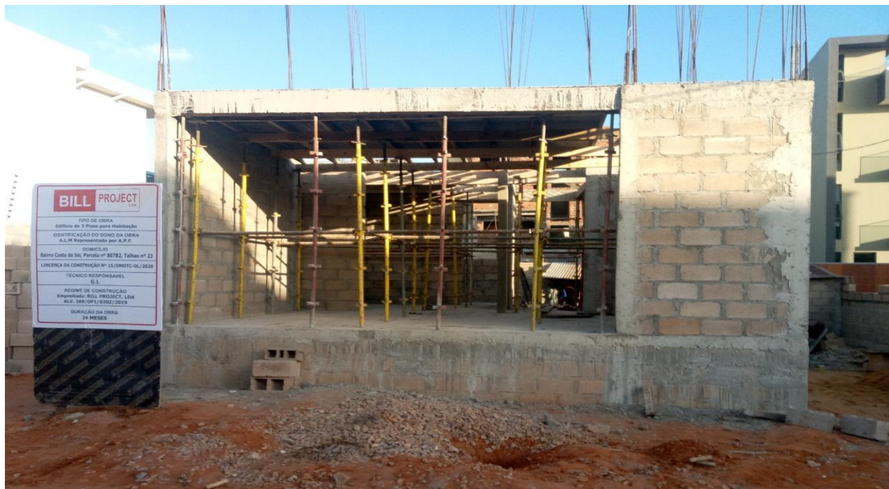
Figura 6: Obra da Bill Project lda.
