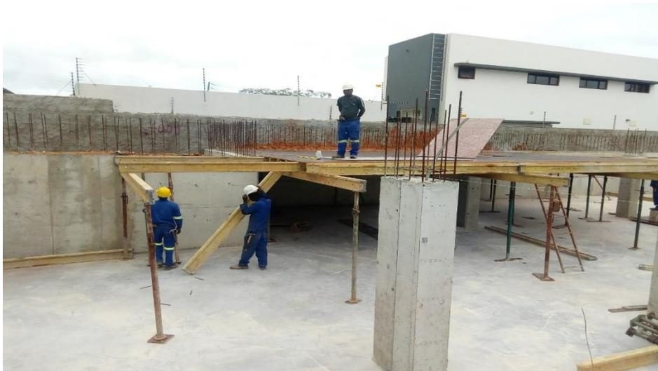
Figura 41: Cofragem da laje do R/Chão (Fonte-autor)
