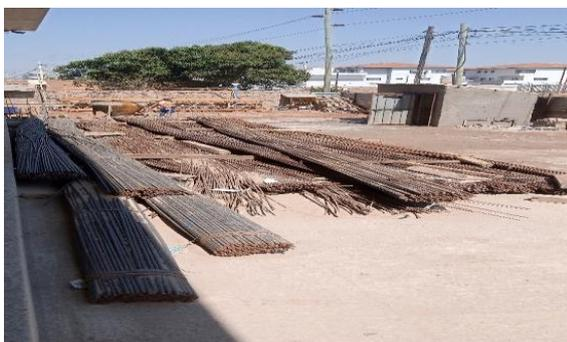
Figura 48: Armazenamento da armadura (Fonte-autor)
