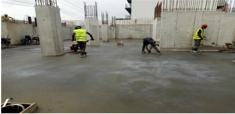
Figura 39: Afagamento da laje de pavimento (Fonte-autor)
