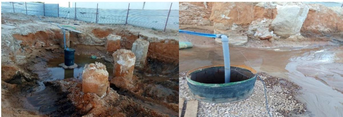
Figura 22: Rebaixamento do nível freático
