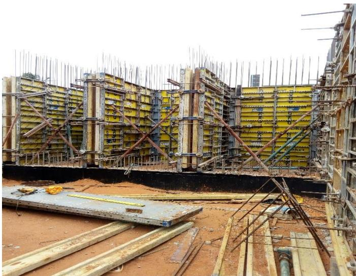
*Figura 52: Cofragem de pilares paredes-requitos de qualidade observados*
