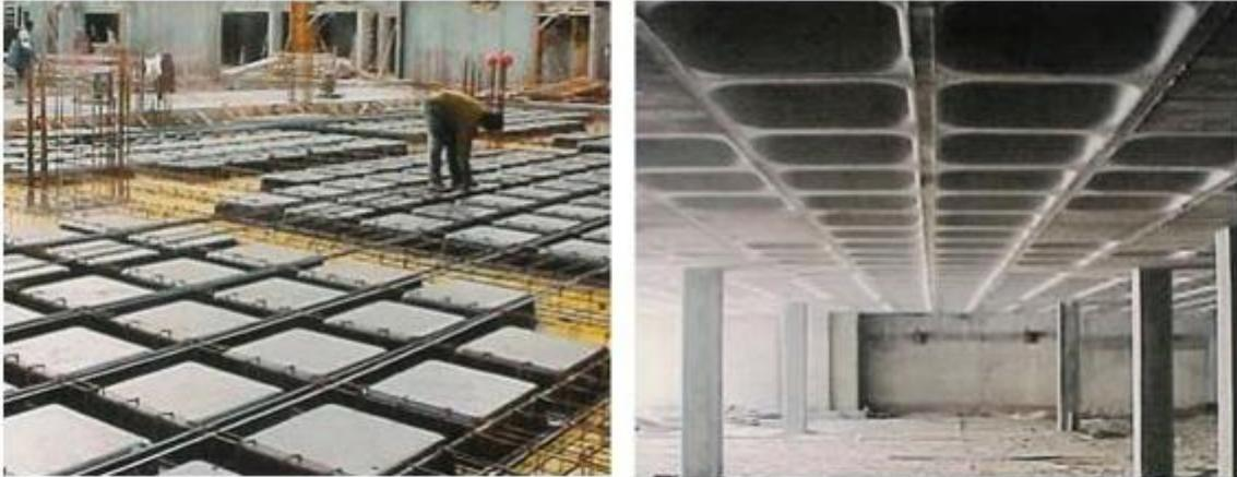
Figura 7:Laje aligeirada com moldes recuperaveis(FERCANORTE, 2011).
