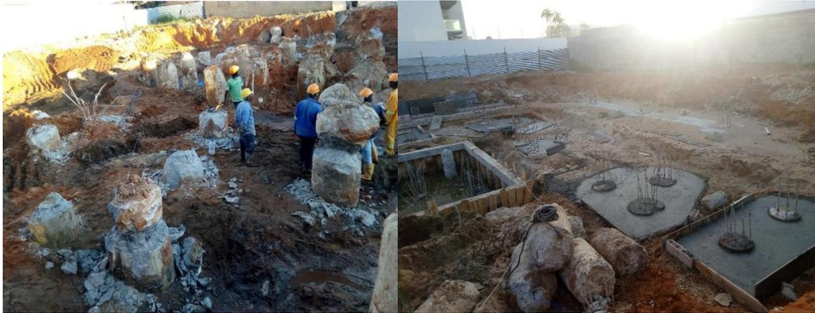
Figura 23:a) Arrasamento de estacas
