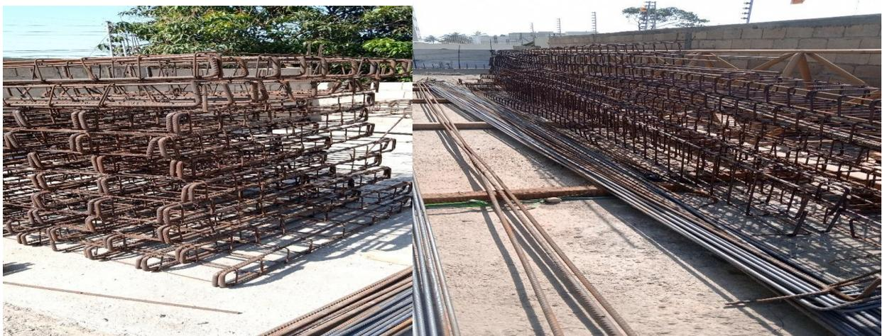
Figura 50: a) Montagem da armadura de capitel
