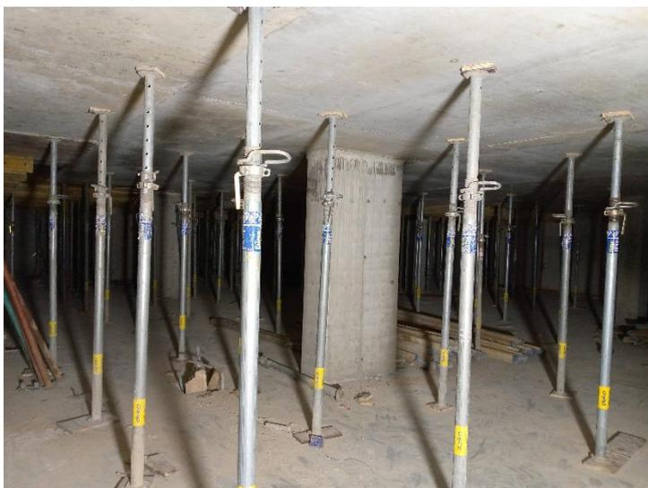
Figura 54: Laje devidamente escorada após a descofragem
