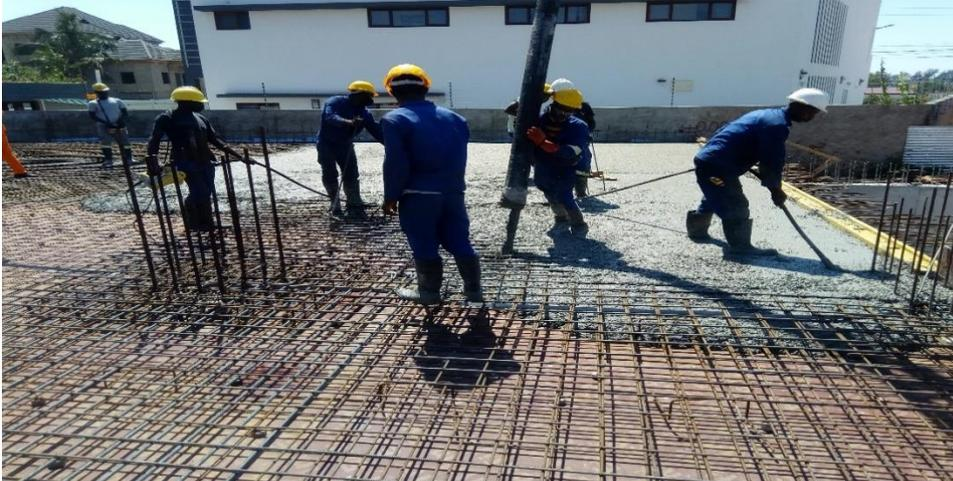
Figura 45: Betonagem da laje do R/Chão (Fonte-autor)
