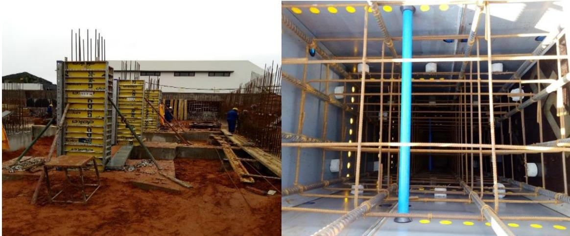
Figura 30: Cofragem dos pilares(Fonte-autor)
