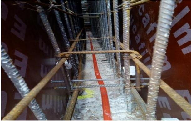
Figura 28:Fita hidroexpansiva(fonte-autor)
