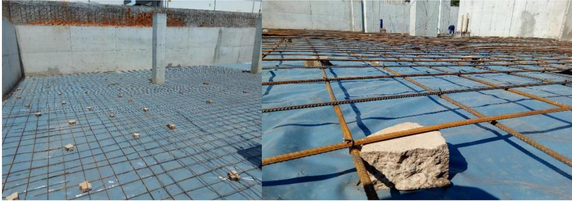
Figura 37: a) Armação da malha da laje      b)Recobrimento da laje ( Fonte autor)
