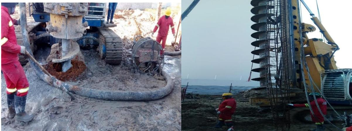
Figura 20: Perfuração de estacas (Fonte-autor)
