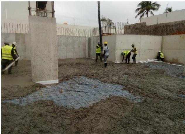
Figura 38: Betonagem da laje de pavimento (Fonte-autor)
