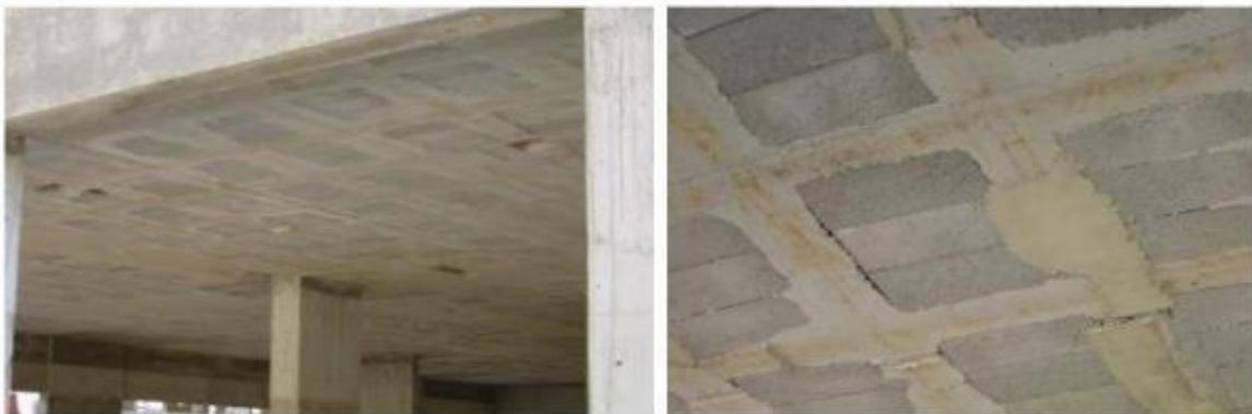
Figura 6: Laje fungiforme aligeirada com blocos perdidos(Ramos, 2006).
