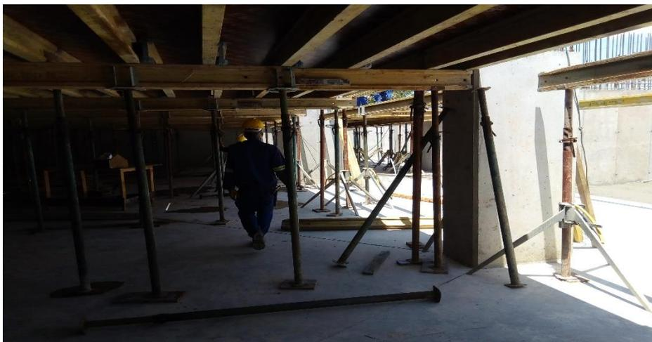
Figura 42: Colocação das chapas de madeira e estaqueamento(Fonte-autor)
