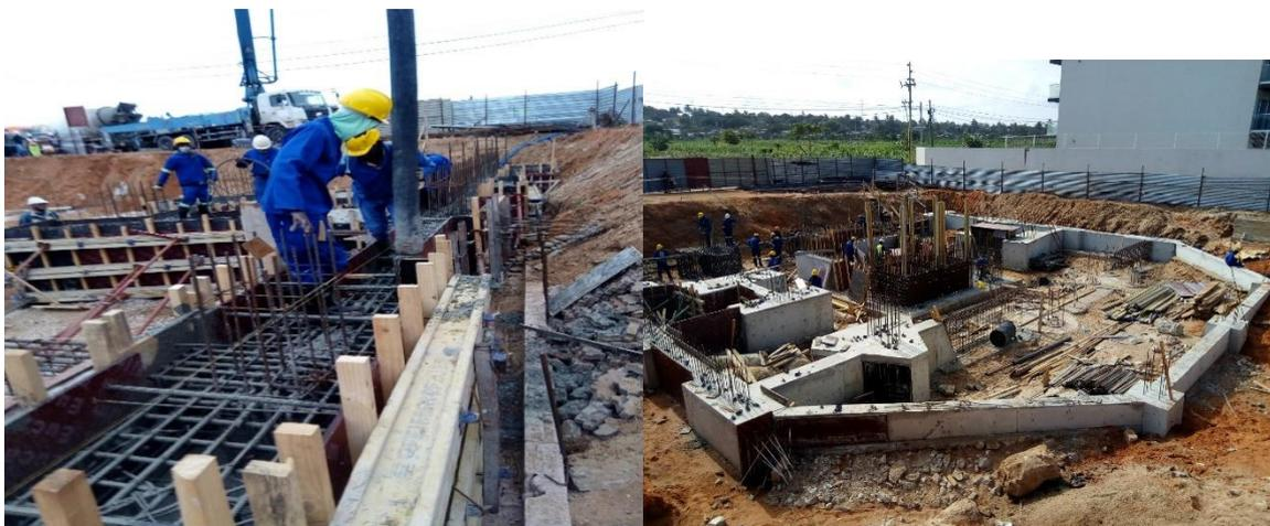
Figura 26:Betnagem dos Maciços, vigas de equilíbrio e Descofrangem dos mesmos(Fonte-autor)
