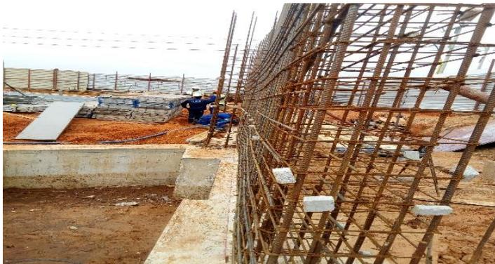
Figura 27: Armação dos Muros de contenção
