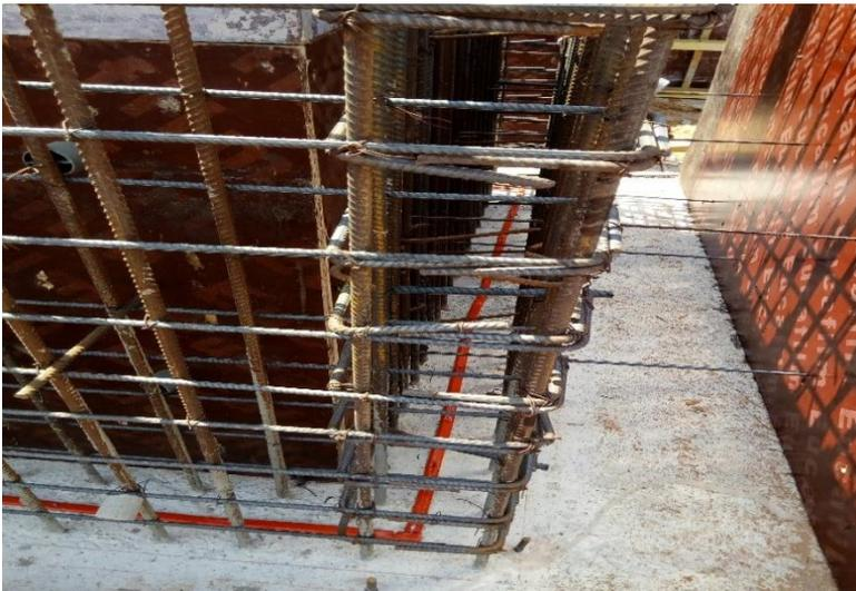
Figura 33:Cofragem dos pilares parede do poço do elevador(Fonte-autor)
