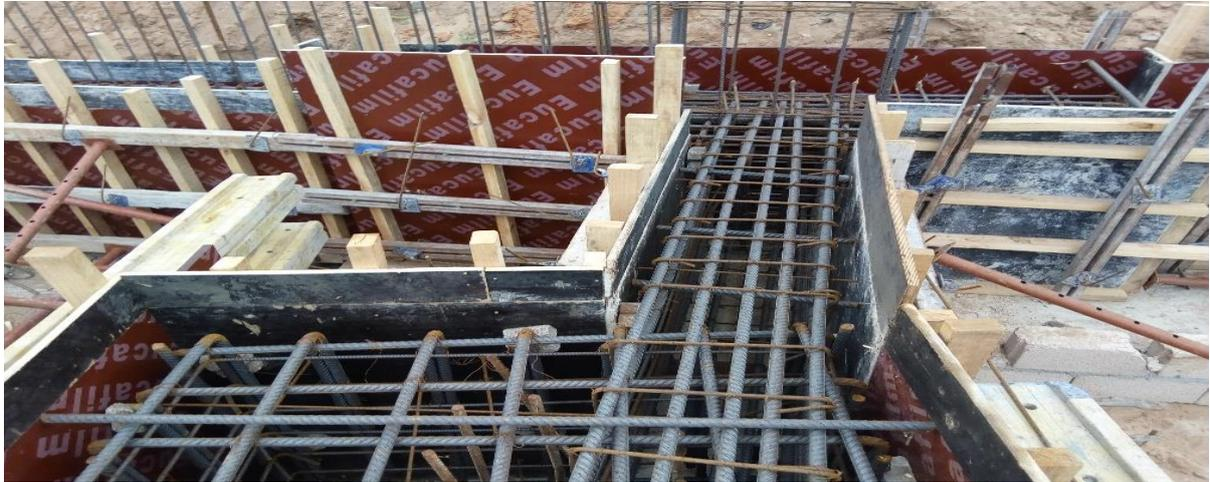
Figura 25:Cofragem dos maciços e vigas de equilíbrio
