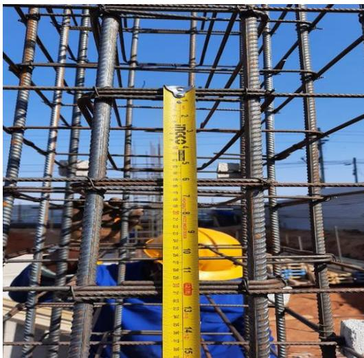
Figura 29:Armação dos pilares
