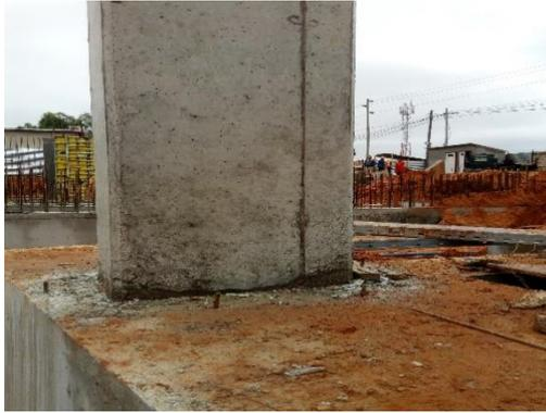
Figura 31: Descofragem dos pilares(Fonte: autor)
