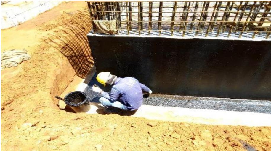
Figura 34: Impermeabilização dos pilares Parede, Poço do elevador (Fonte-autor)
