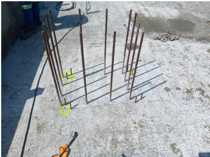
Figura 51:Desvio da armadura(fonte-autor)
