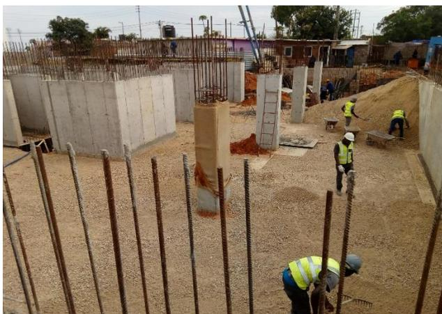
Figura 36: Nivelamento da camada base (Fonte-autor)
