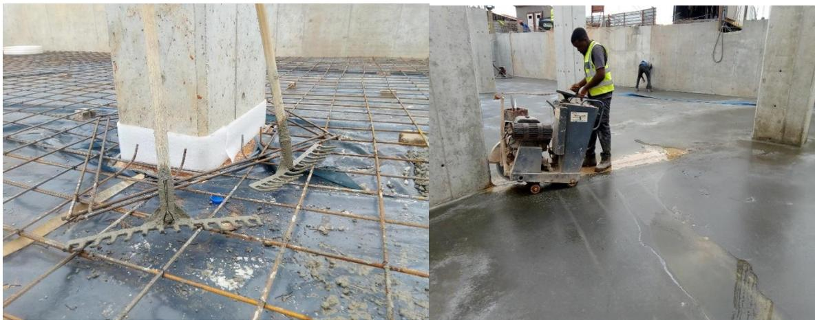
Figura 40: Juntas de dilatação das placas
