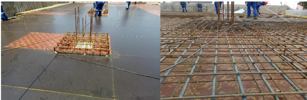
Figura 43:a)Armadura de reforço ao punçoamento
