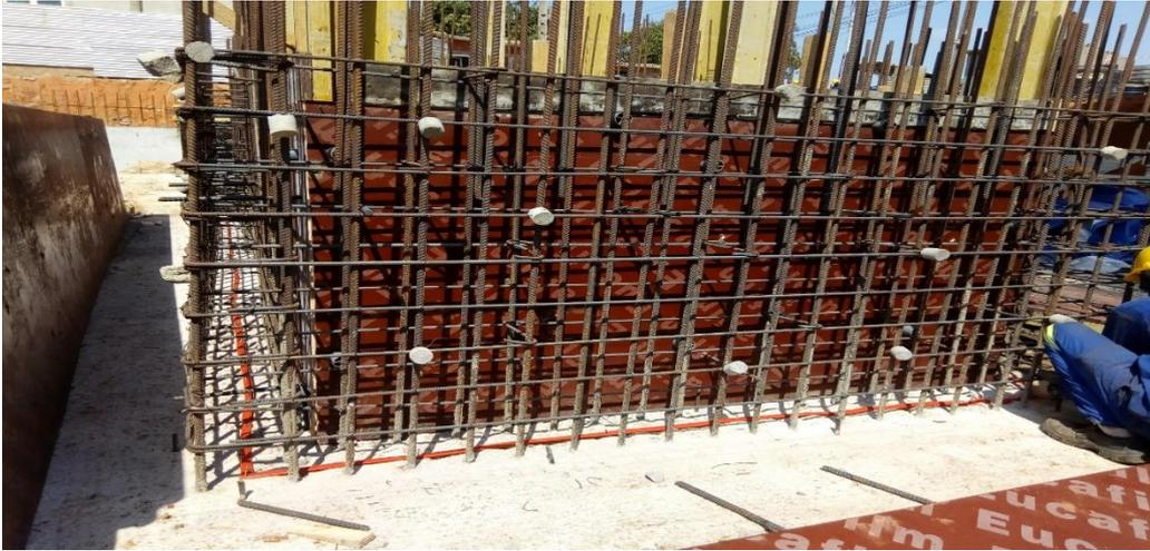
Figura 32: Armação dos pilares-parede, poço do elevador (Fonte-autor)
