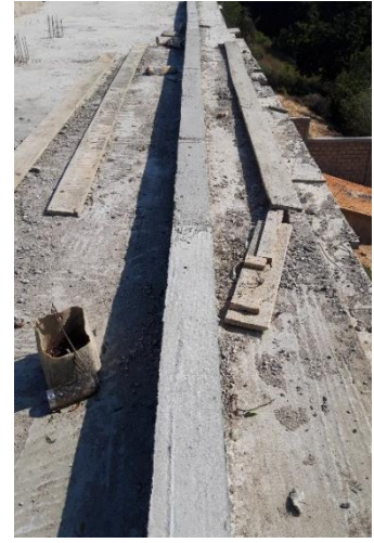
f) Aspecto final da viga
