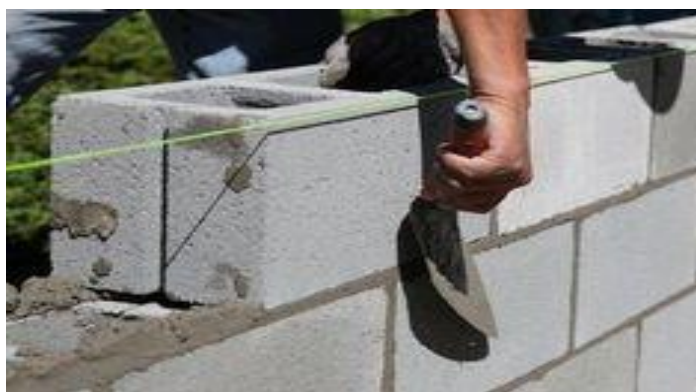
Figura 41 - Assentamento de blocos
