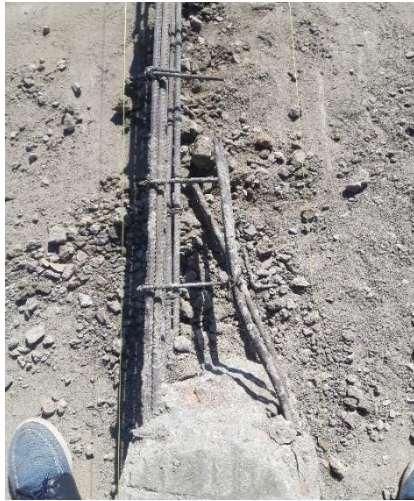
d) Correção do alinhamento da armadura
