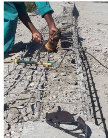
c) Corte de armadura
