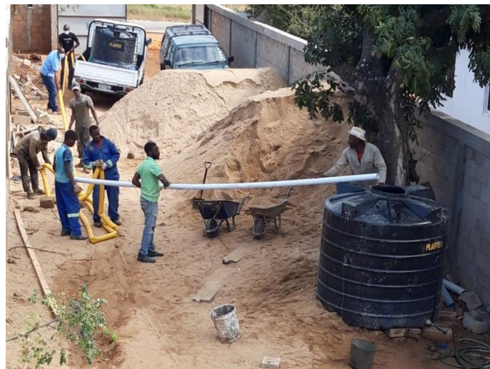
Figura 52 - Reforço de água no momento da betonagem
