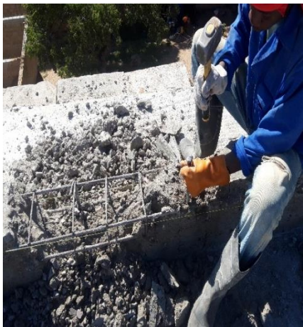
a) Escarificação da viga
