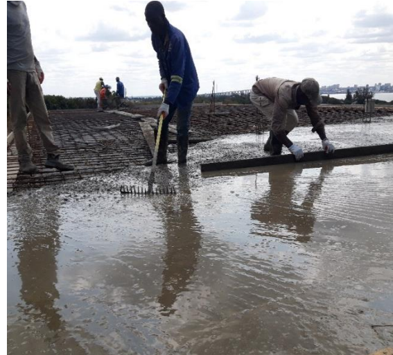
d) Espalhamento e nivelamento do betão
