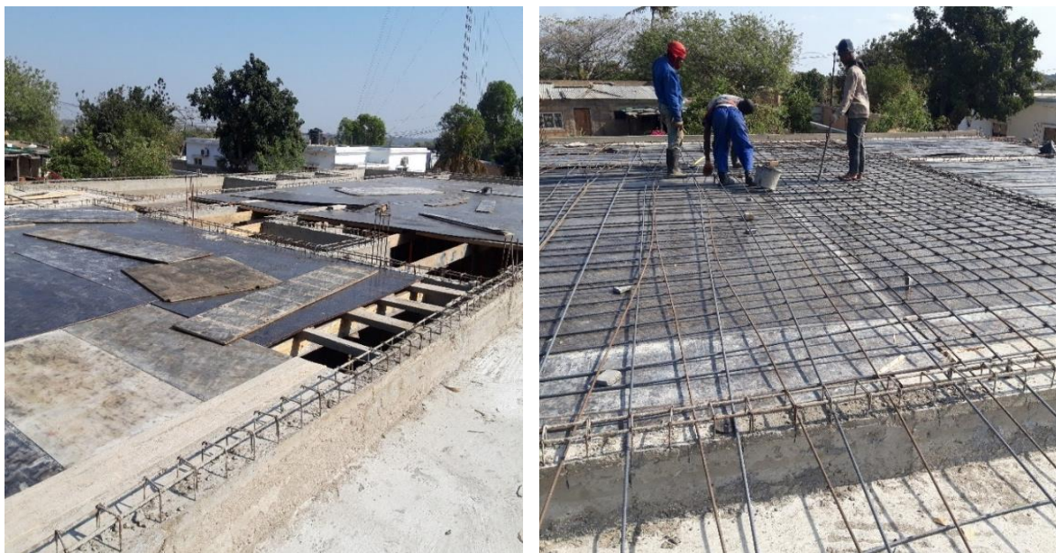
Figura 50 - Sequência da montagem de chapas e colocação da malha
