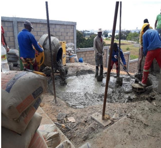
a) Despejo do betão após mistura na betoneira
