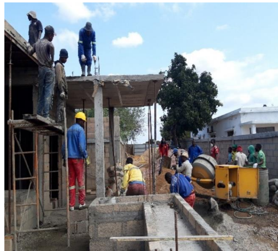
b) Elevação do betão ao nível da laje
