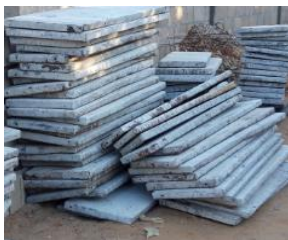
Figura 23 - Chapas metálicas de cofragem
