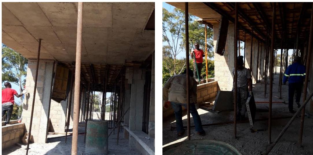
Figura 46 - Descofragem da laje de cobertura (varanda)
