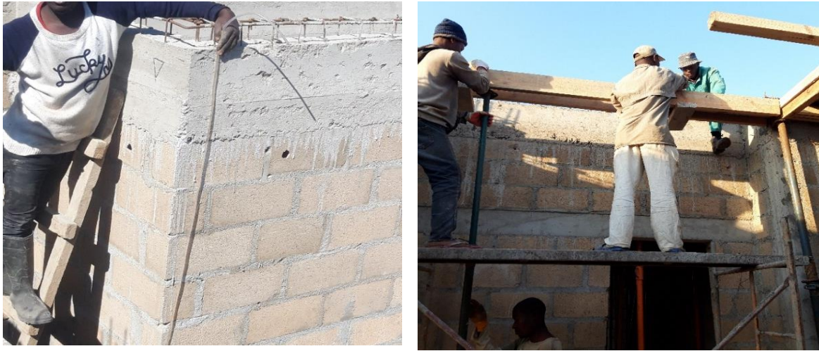
Figura 49 - Sequência do nivelamento e colocação de prumos e barrotes
