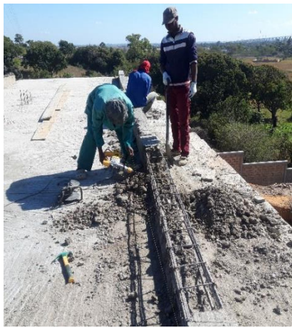
b) Escarificação da viga
