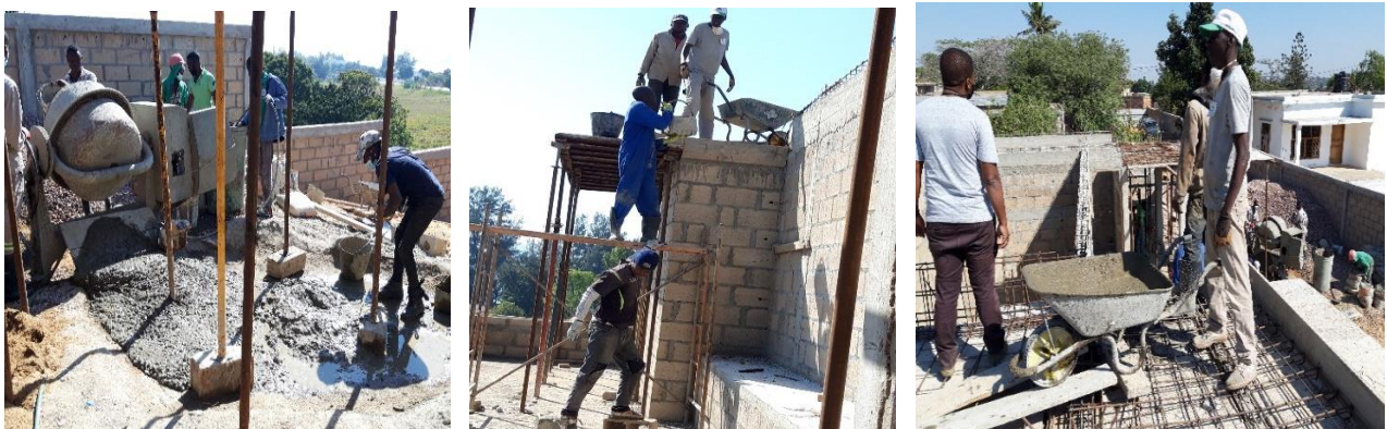
Figura 45 - Sequência do trabalho feito no dia da Betonagem da laje de cobertura (varanda).
