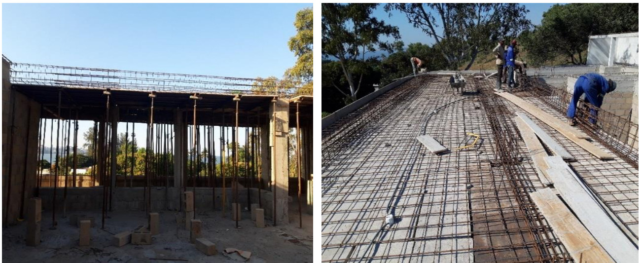
Figura 44 - Preparação da cofragem e colocação de armaduras da laje de cobertura (varanda) e da viga invertida; indicação do andamento das condutas de cabos eléctricos
