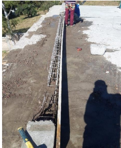
e) Assentamento de nova armadura e cofrage
