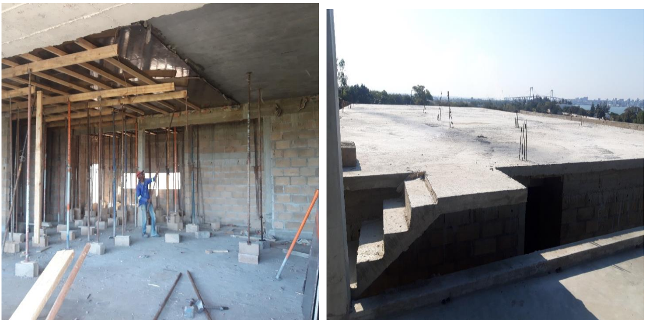
Figura 53 - Processo de descofragem da laje
