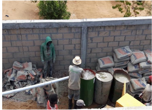
Figura 51 - Processo de betonagem da laje de cobertura
