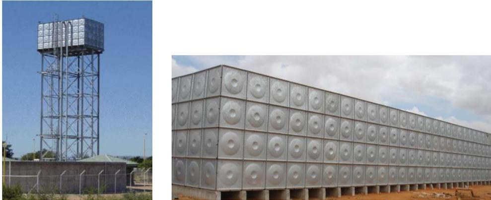
Figura 16: Imagens do tipo de reservatórios metálicos a usar.
