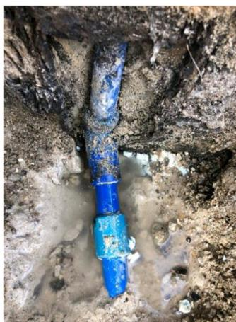
*Figura 14: Vazamento em tubagem enterrada. Fonte: Disponível em: <<https://zerofugas.com/fugas-e-infiltracoes-de-agua>> Acesso em Março de 2022.*
