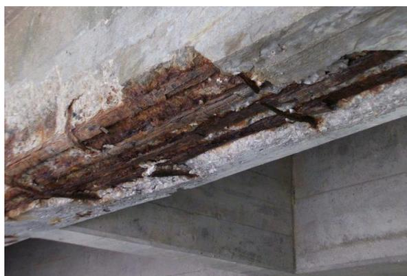
*Figura 8: Corrosão em elementos estruturais materializados em betão armado. Fonte: Disponível em <https://plugin.grupohct.com.br/2018/09/26/curso-corrosao-em-armaduras-de-aco-concreto/>.*
