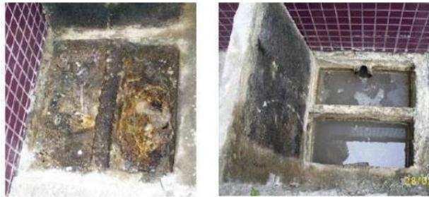
*Figura 18: Caixa de retenção de gordura saturada (à esquerda) e após limpeza (à direita). Fonte: DINIZ (2015 appud SOUZA, 2018).*
