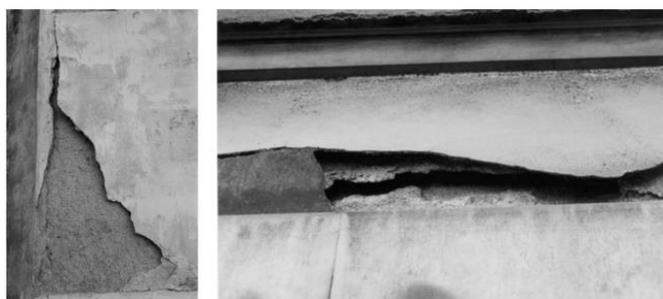
Figura 11: Perda de aderência. Fonte: Ruivo et al. Disponível em: <<https://www.civil.ist.utl.pt/~joaof/ad/08%20-%20Revestimentos%20de%20paredes-%20patologia%20-%20inspec%C3%A7%C3%A3o%20-%20interven%C3%A7%C3%A3o%20-%20PB.pdf>> Acesso em Fevereiro de 2022.
