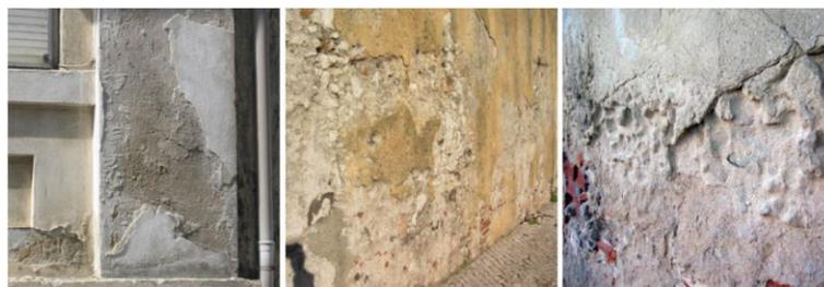
*Figura 12: Da esquerda para a direita, exemplos de pulverização, de arenização e de erosão. Fonte: VEIGA (2004).*
