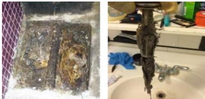
*Figura 16: Caixa de retenção de gordura obturada e entupimento do lavatório sanitário. Fonte: DINIZ (2015 appud SOUZA, 2018).*
