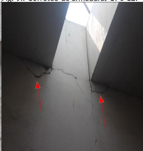
Fig. 13.: Corrosão de armaduras C6 e C7.
