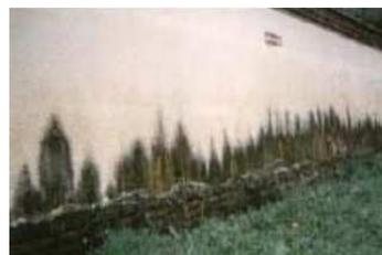
Figura 12: Humidade ascendente de águas superficiais em paredes exteriores (Martins, Jácome, 2005).
