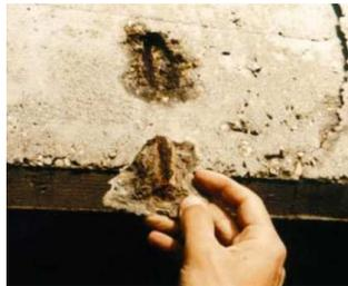
Figura 12: Destacamento de betão provocado pela corrosão de armaduras causada por ataque de cloretos (Branco,2005).
