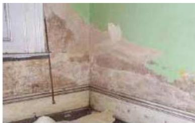
Figura 11: Humidade ascendente de águas freáticas em paredes interiores (Martins, Jácome, 2005).
