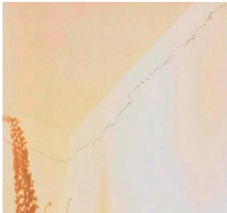
Figura 1: Fissuras inclinadas causadas pela dilatação térmica. (Thomaz, 2020)
