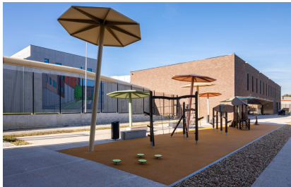
Figura 32. Vista do acesso principal para a prisão Haren. Fonte: EGM architects, 2022
