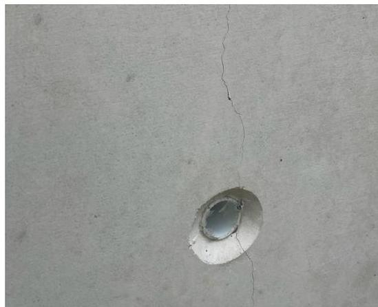
**Figura 4.8:** Fissura de retracção na parede em betão branco
