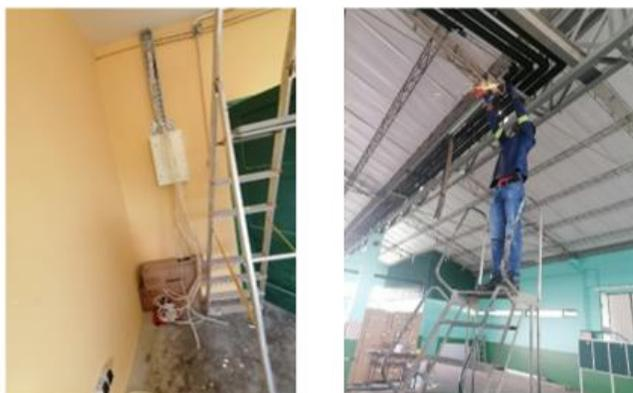
**Figura 3.7:** lançamento de cabos e montagem de tomadas de corrente
