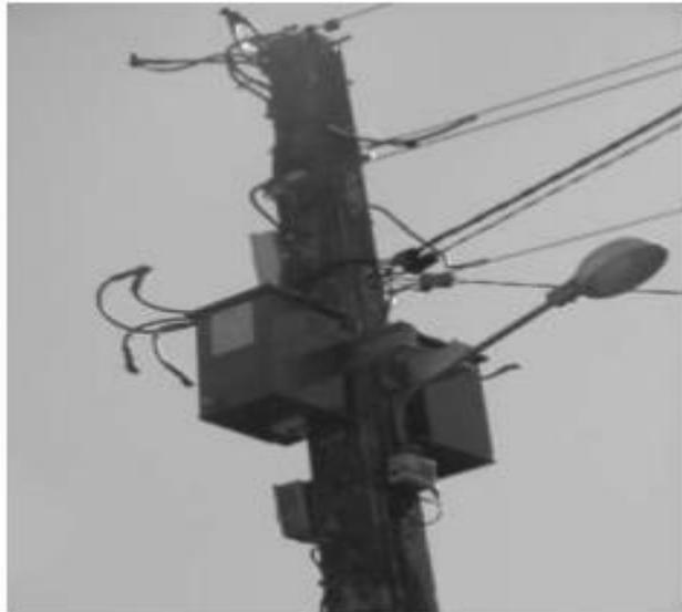
*Figura 11: Dois reguladores de alta eficiência instalados numa rede rural. Fonte: Adaptado de [2].*
