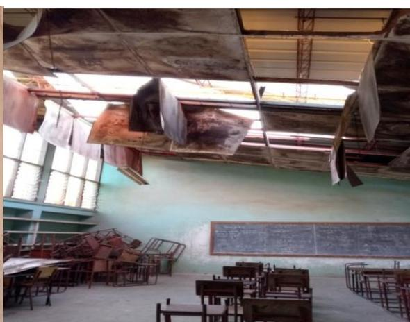
Ilustração 4: Estado de degradação do tecto do corredor e da sala de aula da escola.
