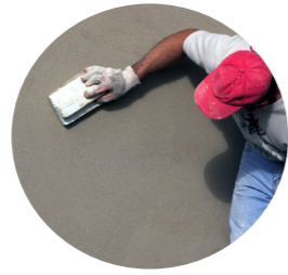
Blocos de Cimento rebocados Fechamento perimetral
