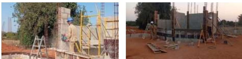
**Figura 4.9:** Cofragem dos pilares.
