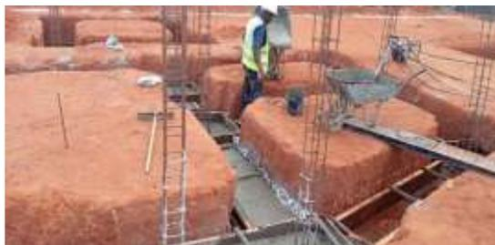
**Figura 4.7:** Betonagem de sapatas corridas e isoladas.
