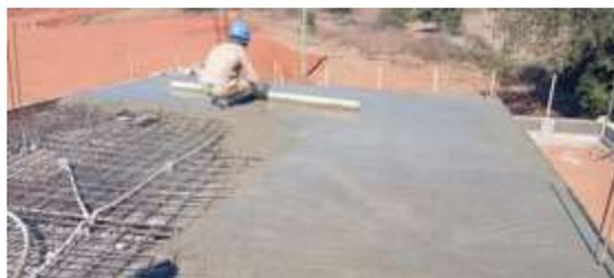
**Figura 4.13:** Betonagem da laje.
