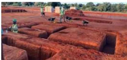
**Figura 4.6:** Abertura de caboucos em fundações isoladas e corridas.
