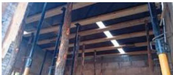
**Figura 4.11:** Cofragem da laje.
