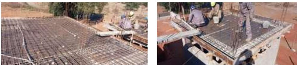
**Figura 4.12:** Colocação de armaduras na laje.
