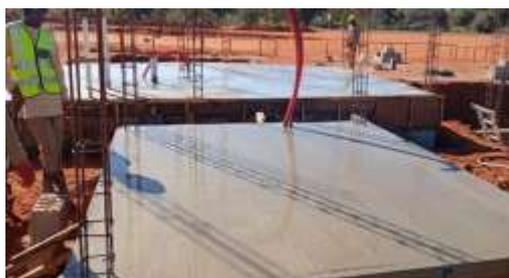
**Figura 4.8:** Betonagem da laje de pavimento da loja de conveniências e casa de baterias.
