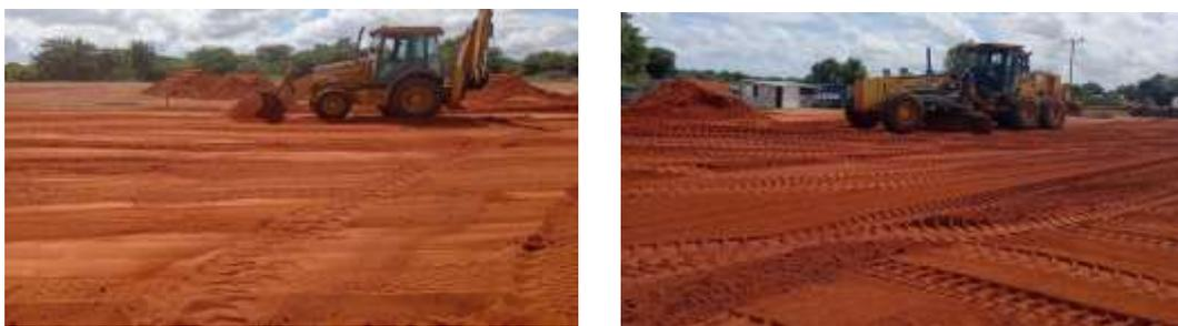
**Figura 4.2:** Nivelamento do terreno.
