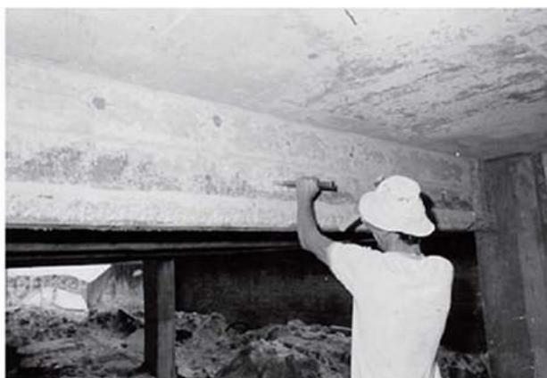
Figura A1. 3 – Picotagem manual do betão degradado nos elementos estruturais
