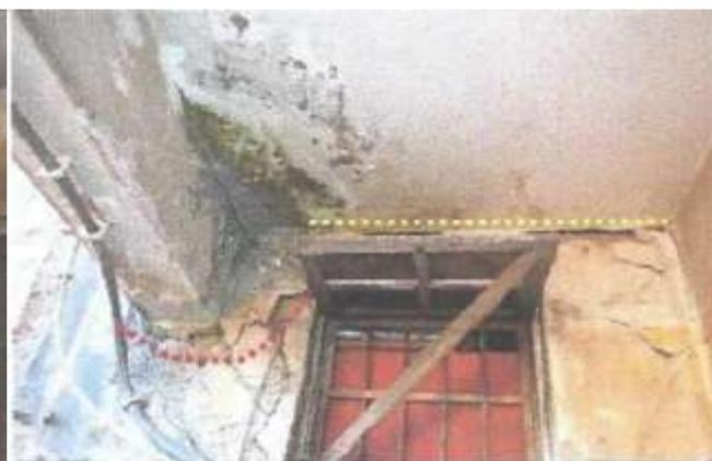
Figura 58. Esmagamento entre a parede e a viga G2 (viga apoiada à parede sem pilar)
