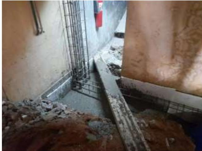
Figura 73. Betonagem de sapatas e viga de equilíbrio
