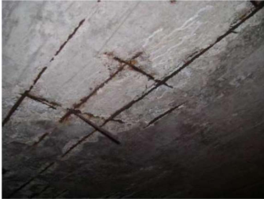
Figura 11. Corrosão nas armaduras de uma laje. Fonte: (Gonçalves, 2015)
