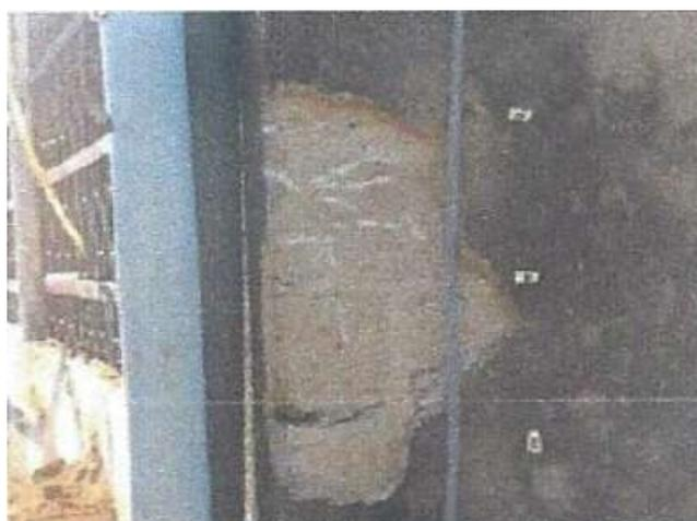
Figura 59. Inexistência de pilar no canto G8
