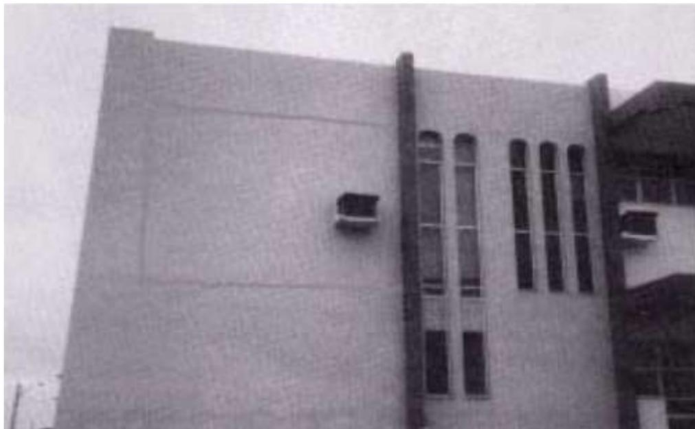
Figura 20. Fissuras de descolamento por movimentação térmica da estrutura de Betão armado (Magalhães, 2004)
