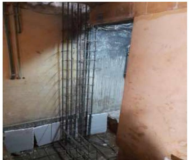
Figura 72. Execução das malhas de sapatas, viga de equilíbrio e pilares
