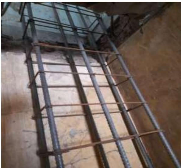
Figura 71. Passagem do pilar P1E pela laje da cave
