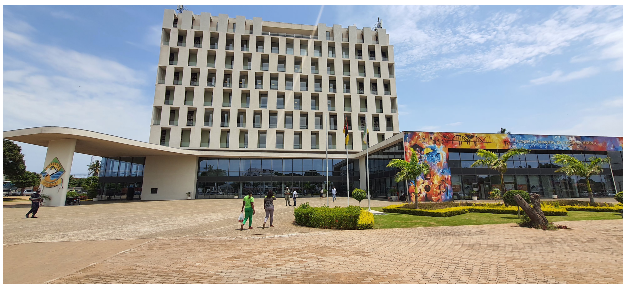
Figura 3.1: Edifício-sede do Conselho Municipal da Cidade da Matola, Fonte: O Autor, Abril de 2025
