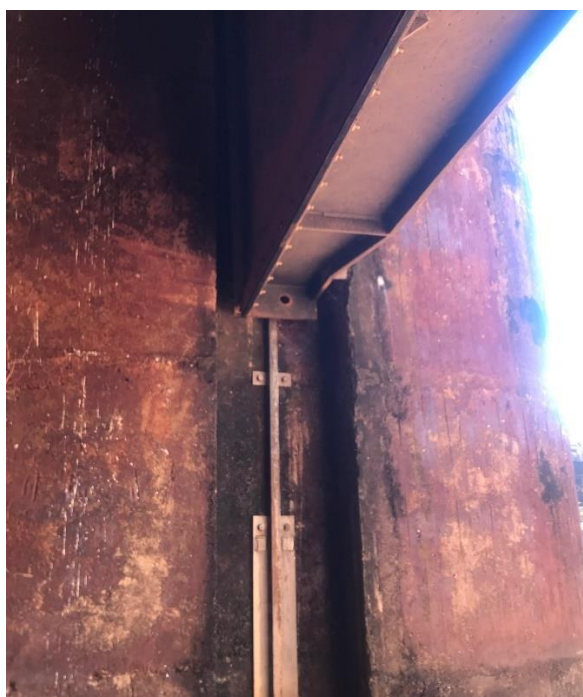
Figura A1.3-1: Ranhuras próprias abertas no maciço da base do edifício.
