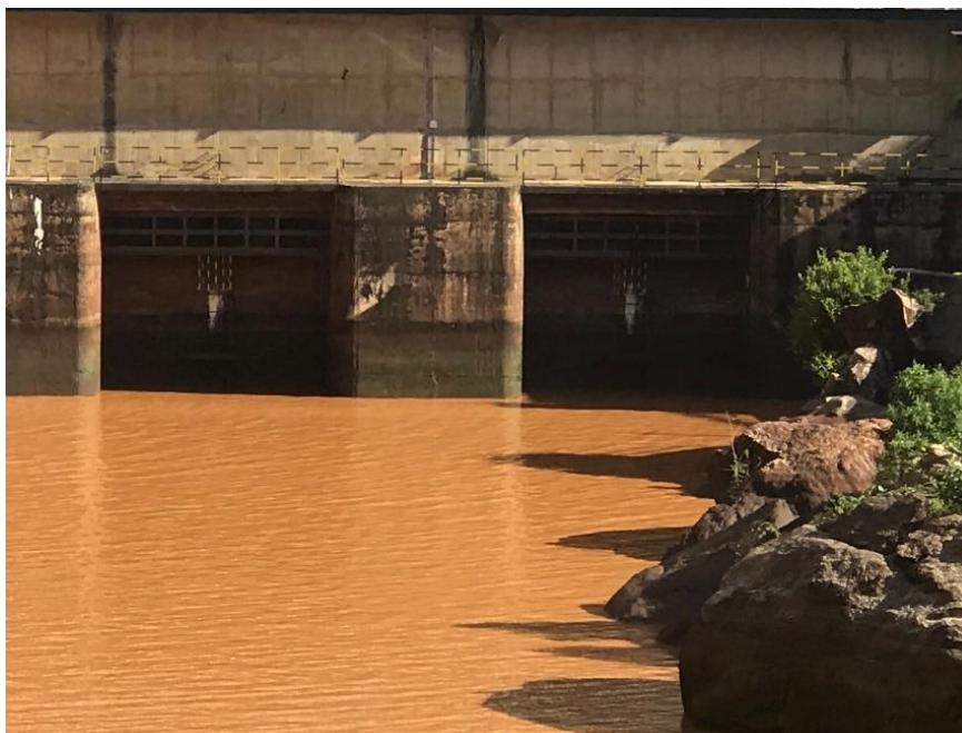
Figura 16: Comportas a Jusante da Central da Chicamba.
