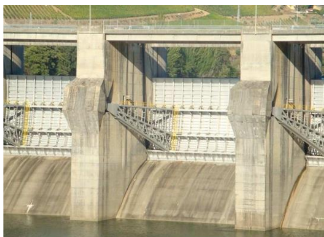
Figura 1: Comportas de segmento [16]
