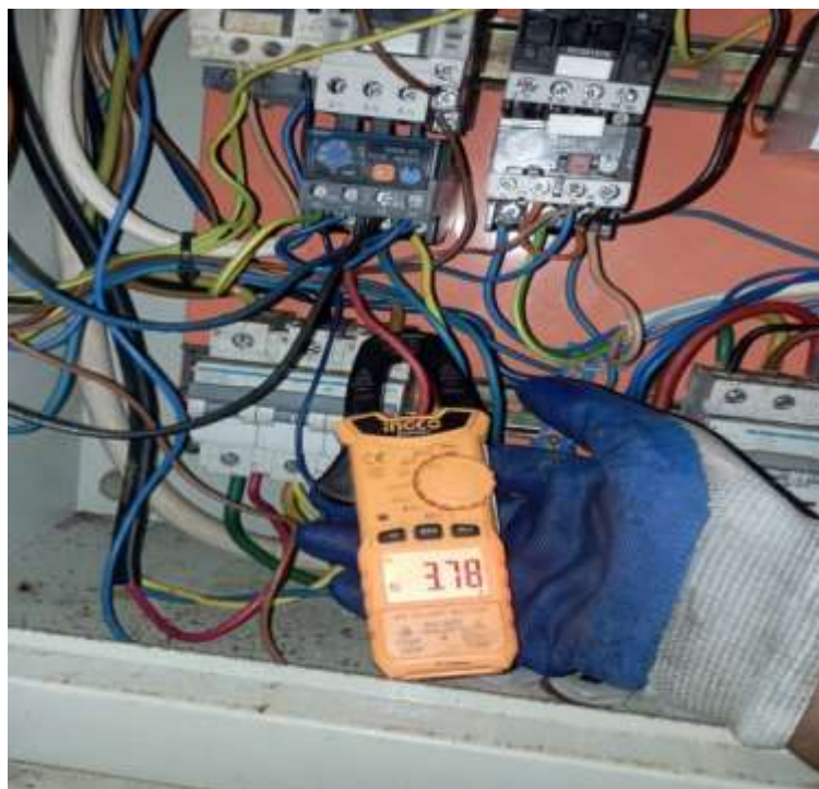
Figura A1.1-2: Corrente do motor do compressor de ar
