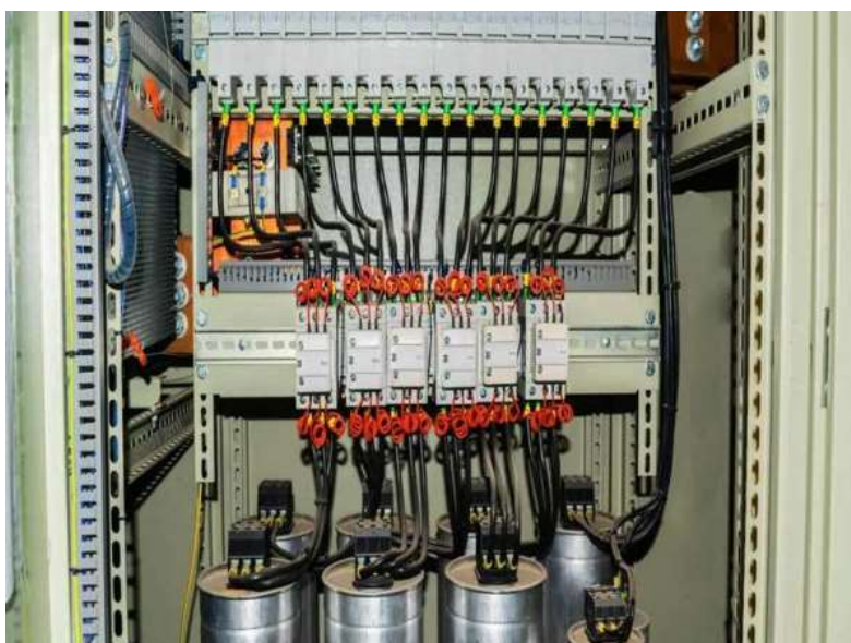
Figura A1.2-2: Banco de capacitores
