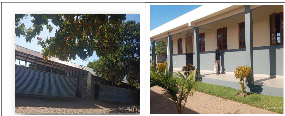
Figura 1: Imagem salas de aula de material misto e do bloco administrativo
