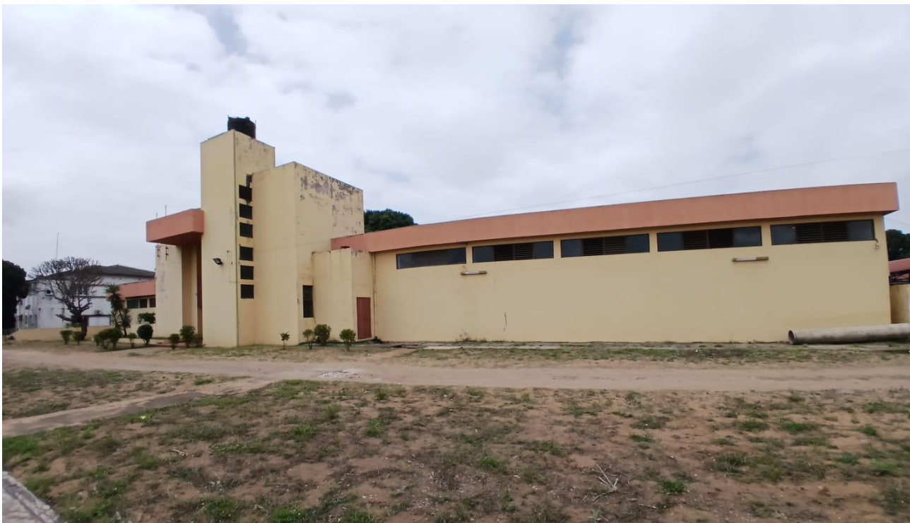
Figura 21: Vista exterior do edifício Ex laboratório de Hidráulica, 02
