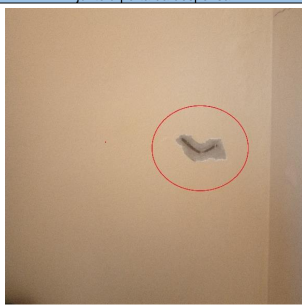
B1.1) destacamento do recobrimento e exposição da armadura transversal com sinais de corrosão;
