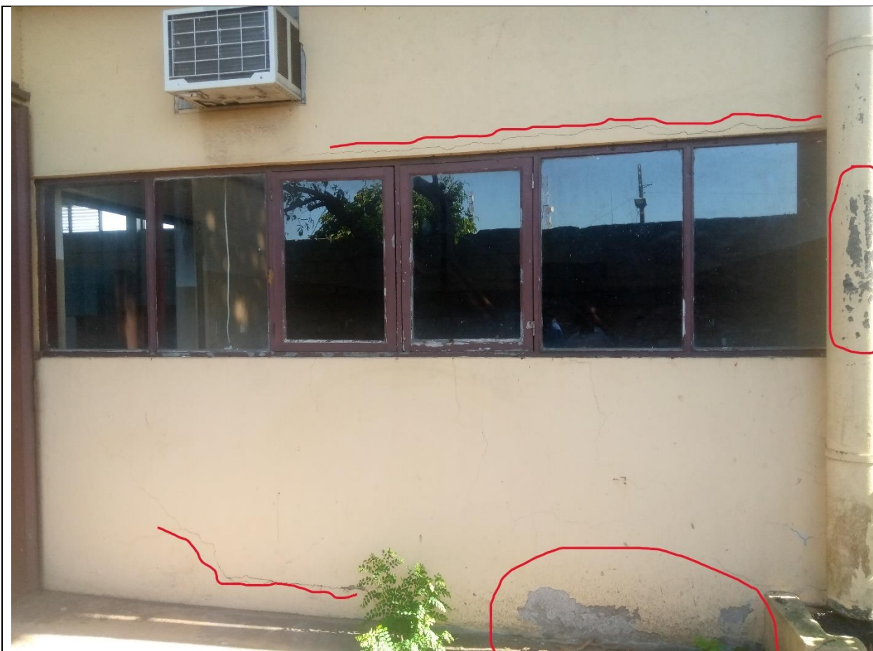
Fe.7) fissura horizontal no lintel da janela e na parede; De.5) destacamento da pintura na parede e janelas, e, no tubo de queda de água.
