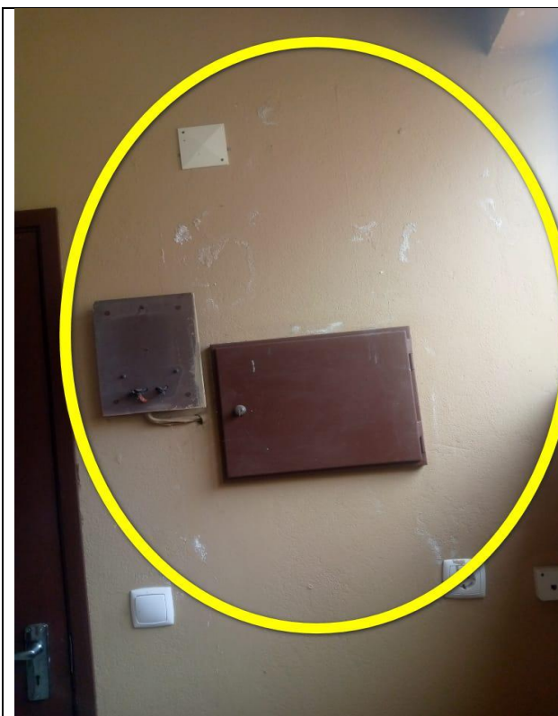
M1.3) Eflorescência na parede frontal da copa
