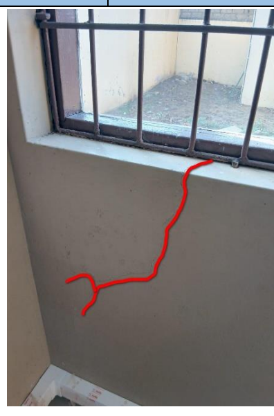
F0.4) Fissura horizontal na base da parede lateral do escritório 1
