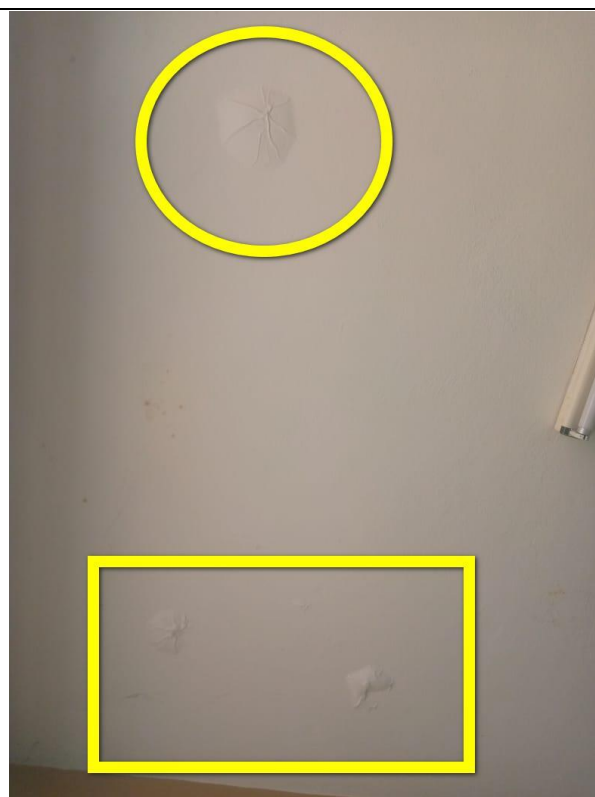
M1.4) Bolhas de humidade na laje de cobertura da copa
