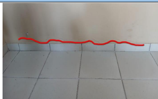
F0.4) Fissura horizontal na base da parede lateral do escritório 1
