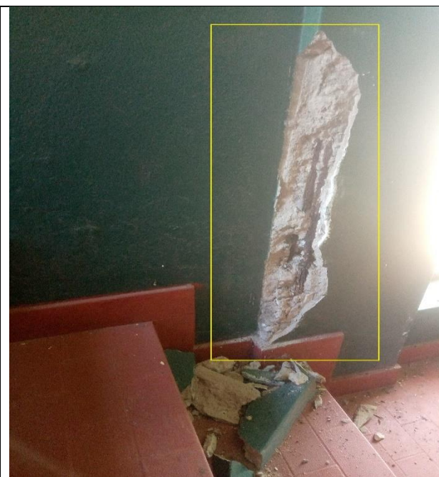
B2.1) Destacamento do recobrimento no pilar, exposição e corrosão da armadura longitudinal; B2.2) Destacamento e delaminação do recobrimento no lintel de janela.
