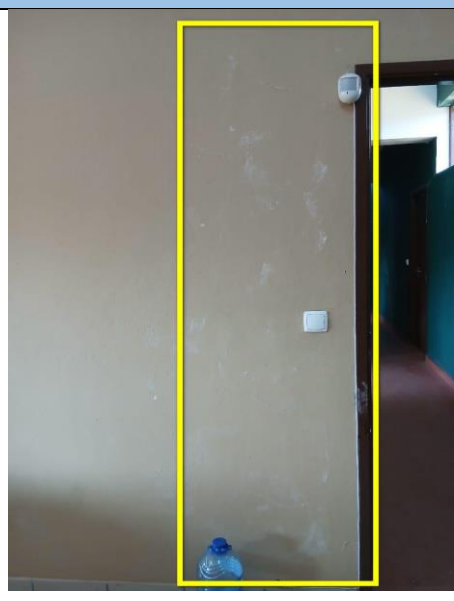
D0.1) Destacamento da pintura na parede e eflorescências.
