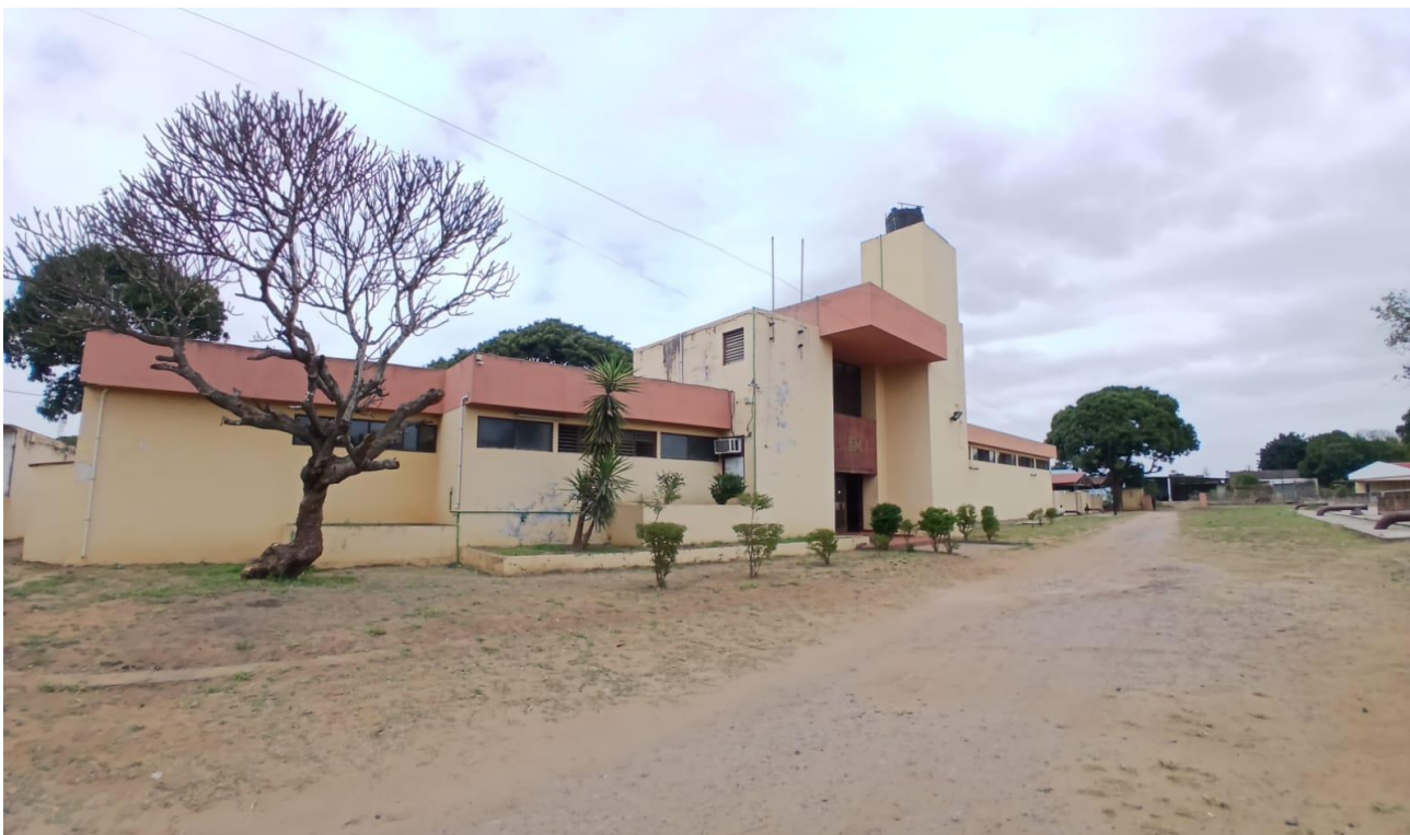
Figura 20: Vista exterior do edifício Ex- laboratório de Hidráulica, 01
