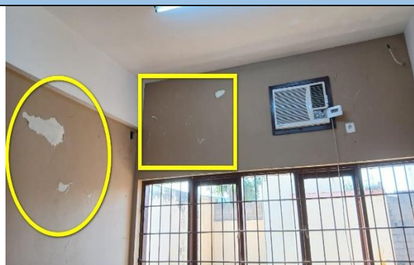
D0.1) Destacamento da pintura na parede e eflorescências.
