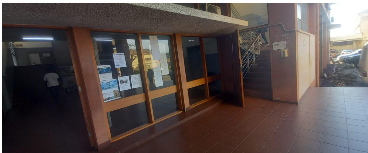
Figura 15: Comunicados colocados no local impróprio – vidros de um edifício
