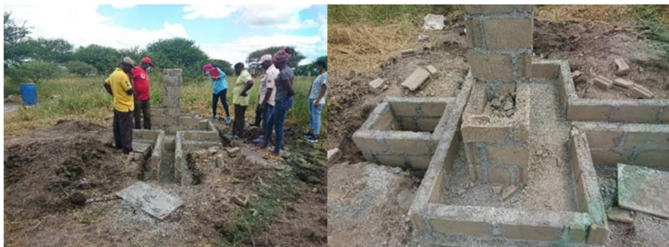
Figura 5: Fontenária em processo de construção num ponto intermédio entre a escola e posto de saúde.
